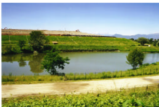
Figura 25 Veduta dei rilevati perimetrali di contenimento in corso di progressivo recupero.
