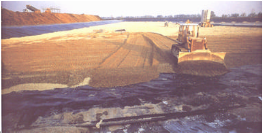
Figura 10 Preparazione del fondo della discarica.
