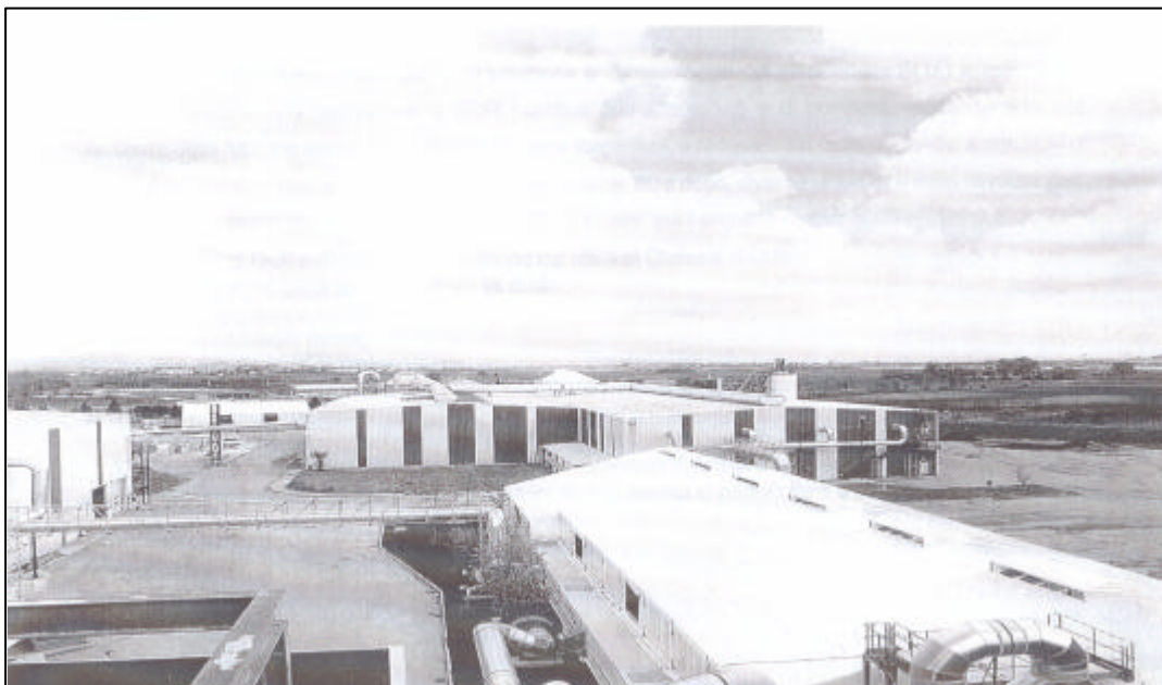
Figura 31 Impianto di separazione dei rifiuti urbani e assimilabili con recupero della frazione secca, dei materiali ferrosi e compostaggio aerobico della frazione organica. ( Ente gestore DANECO.ud)
