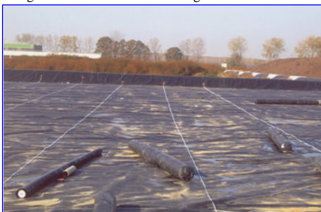
Figura 37 Disposizione della rete di elettrodi paralleli sopra la geomembrana.
