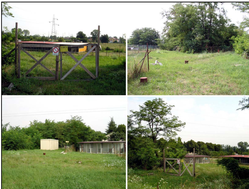
Figura 3.1 Panoramica del cantiere di bonifica
