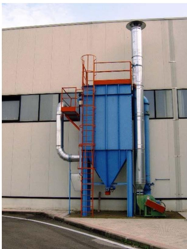
*Figura n° 4.5 : Abbattimento polveri di smalteria dell'impianto mattonelle*
