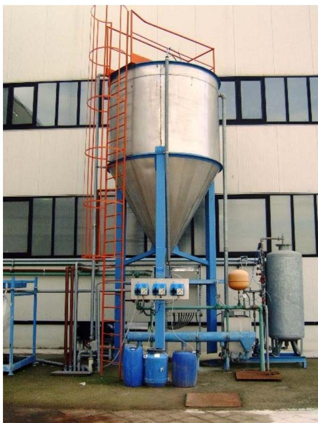
*Figura n° 4.3 : Trattamento chimico-fisico dei reflui da impianto mattonelle*
