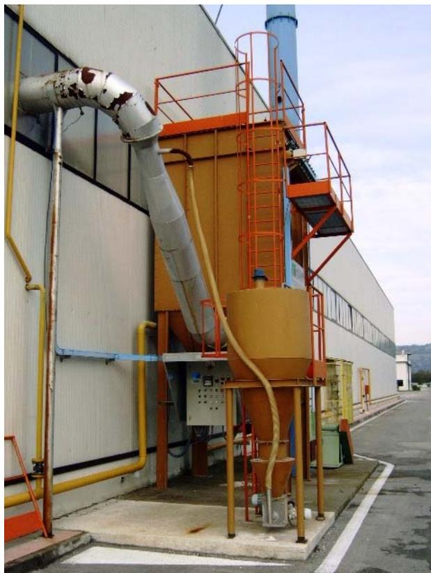
*Figura n° 4.6 : Abbattimento fumi del forno dell'impianto mattonelle*
