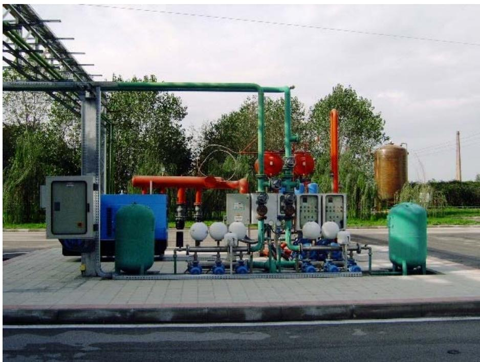
*Figura n° 3.12 : Impianto antincendio e stazione di pompaggio acqua di processo*
